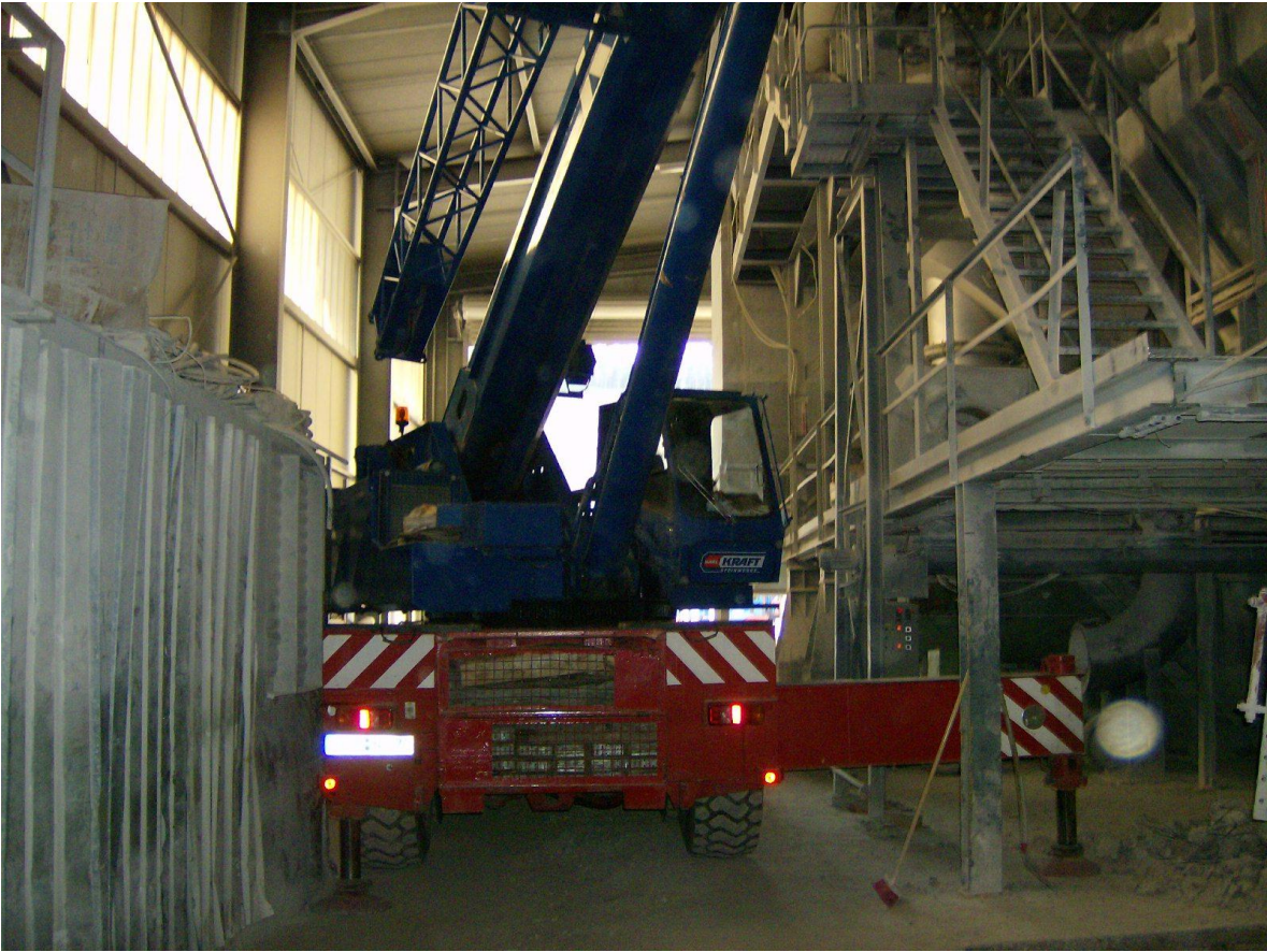
Milimeterarbeit: Mühle wird mit dem Autokran in der Halle heraus gehoben
